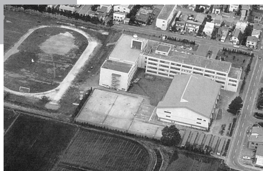
新校舎全景（平成4年頃）
