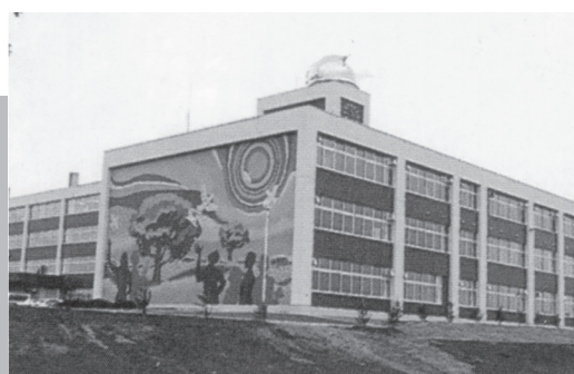
平成2年3月に完成した特別教室棟
